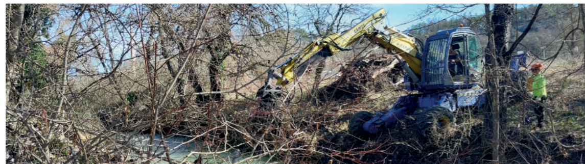
Travaux sur le Lauzon - Photo : SMAVD
