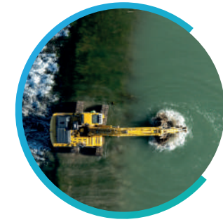
Lancement des travaux
