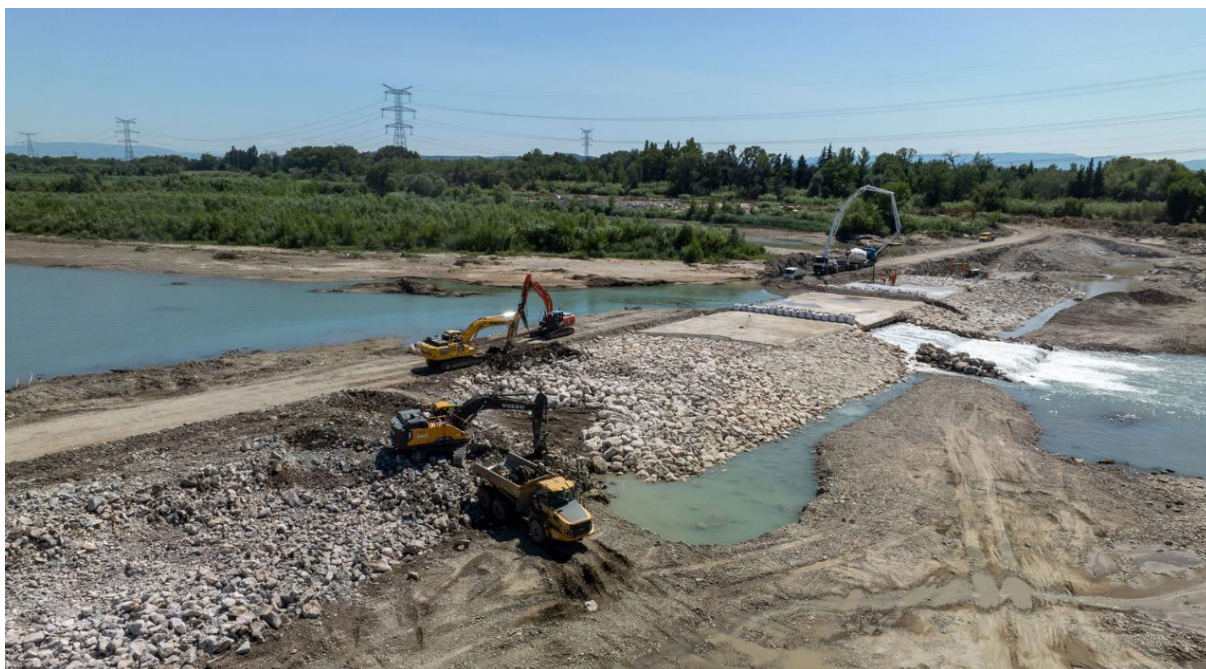
Vue générale des travaux sur le seuil 68 au 20/08
