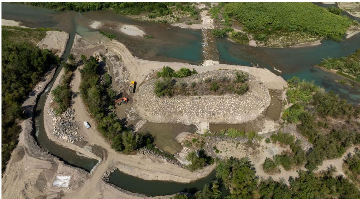
Vue générale des travaux sur le seuil 66 au 20/08
