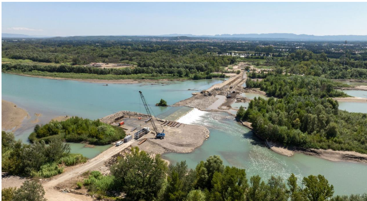
Vue générale des travaux sur le seuil 67 au 20/08
