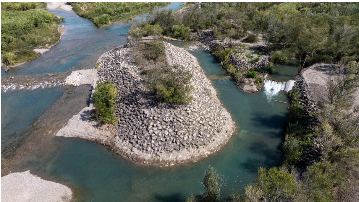
Rivière de contournement à la fin du chantier (semaine 38)
