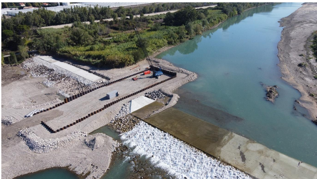
Rideau de palplanches en train d'être finalisé sur le seuil 68 (semaine 38)
